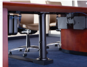
Túnel de transición
