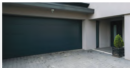
Portones eléctricos en cochera
